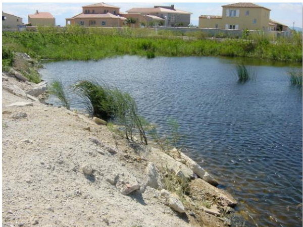
Remblaiement d'une mare. Crédit : Tour du Valat.
