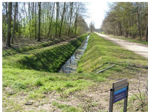
Watringue. Ce terme désigne un réseau de fossés et d'ouvrages de drainage à vocation de dessèchement dans les polders du Nord de la France. Photo : Domaine public.
