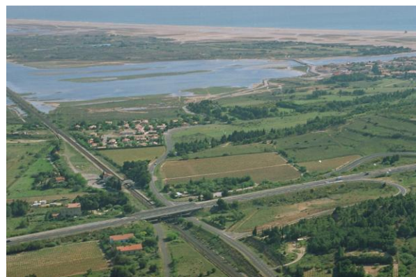
Infrastructures routières en bordure d'une lagune. Photo : FONBONNE.
